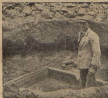
Budowa dna zbiornika.
