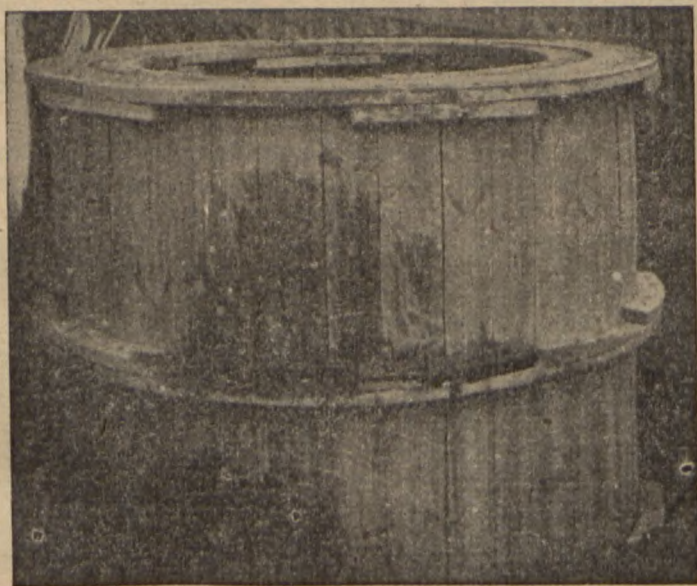
Forma drewniana do budowy zbiornika betonowego o średnicy 2 m. i wysokości 3 m.
