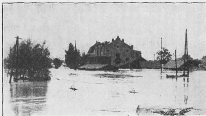
Ryc. 4. Zatopiona elektrownia w N. Sączu.
