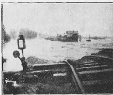
Ryc. 6. Zerwany nasyp kolejowy wraz z szynami pod Bogumiłowicami.
