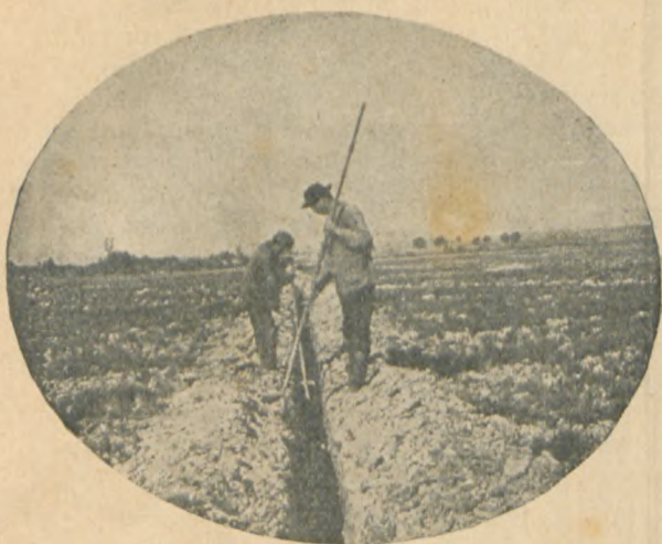
Rowek drenowy — układacz z pomocnikiem układają na dnie rowka rurki drenowe z pomocą haka osadzonego na długim trzonku.
