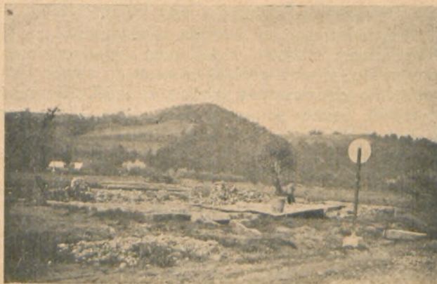
Rozrzucone kamienie fundamentów są jedyną pozostałością zagrody.
