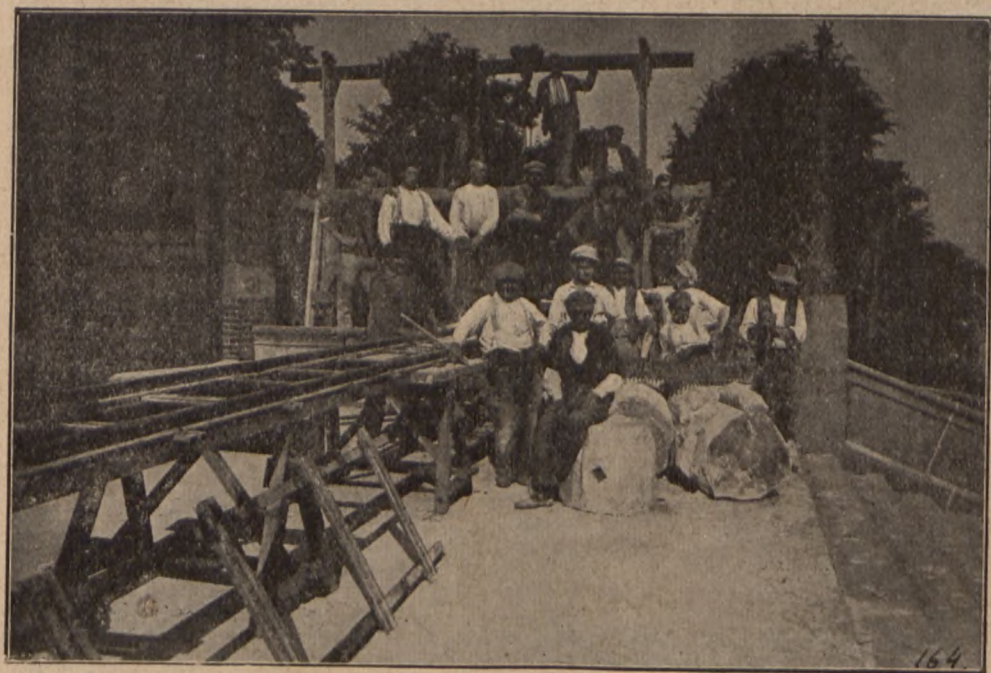
Robotnicy polscy przy odbudowie zrujnowanego kościoła w Amiens, Francja.
