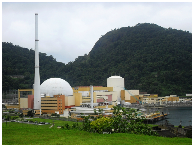
Elektrownia jądrowa ANGRA (fot. Wikipedia).
