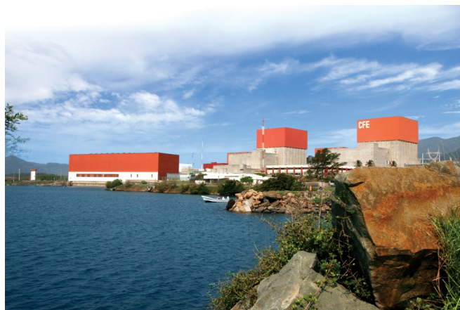
Elektrownia jądrowa Laguna Verde (fot. Wikipedia)
